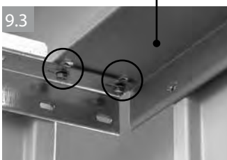
Kopfprofil Vorderwand | top section, front wall profil de tête paroi avant | kopprofiel voorwand
