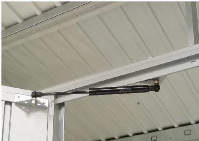
**2.** Bringen Sie auch mittig über dem Türflügel links eine **große Konsole für die Gasdruckfeder** auf dem Alu-Kopfprofil der Vorderwand an. Die Muttern ziehen Sie bitte sofort fest.
